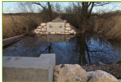
Betonfundamente mit Steinverbau auf beiden Seiten
